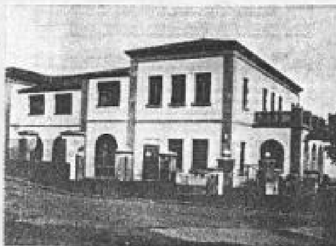
El edificio del Colegio Nacional "Luis Vives" antes de ser derribado por el incendio que fue ordenado por el alcalde de los alpujarreños. Fotografía tomada por D. Francisco Rodríguez Cordero en 1956.
